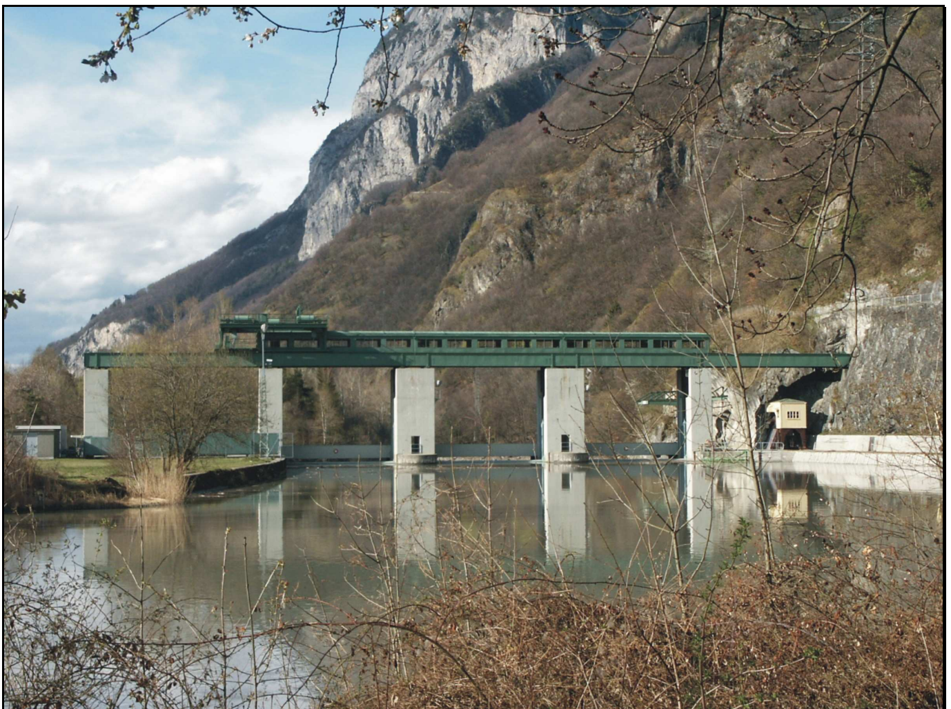
Barrage de l'usine de Lavey
