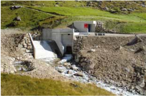
Wasserfassung Stauwehr, Kiesfang, Steuerraum und Umgehungsgerinne
