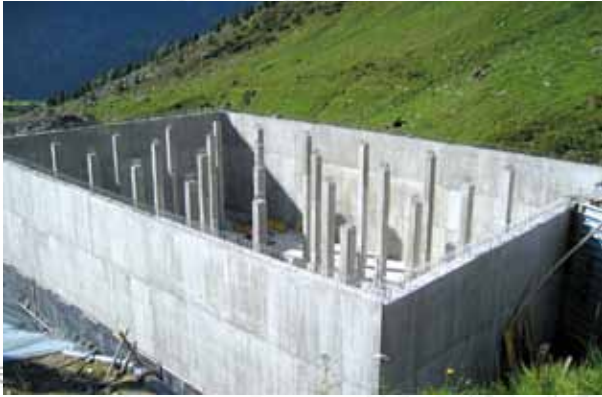
Ausgleichskammer Volumen 3'500 m 3
